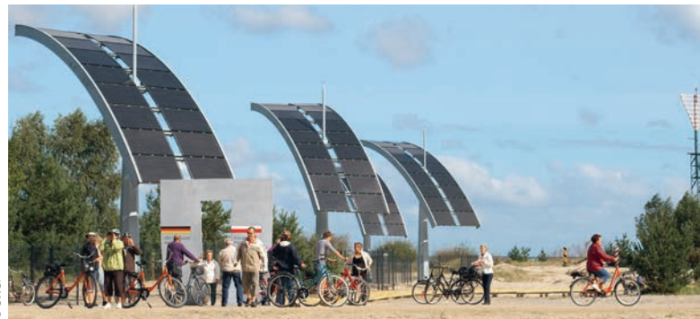
Entlang des Steges am Grenzplatz werden eigens von SWUP entworfene Solar-Tracker in Form von »Photovoltaiksegeln« zur Stromerzeugung genutzt.
